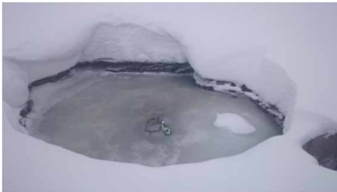
Рис. 3. Прорыв водопровода (материалы хоздоговора №17.65)
