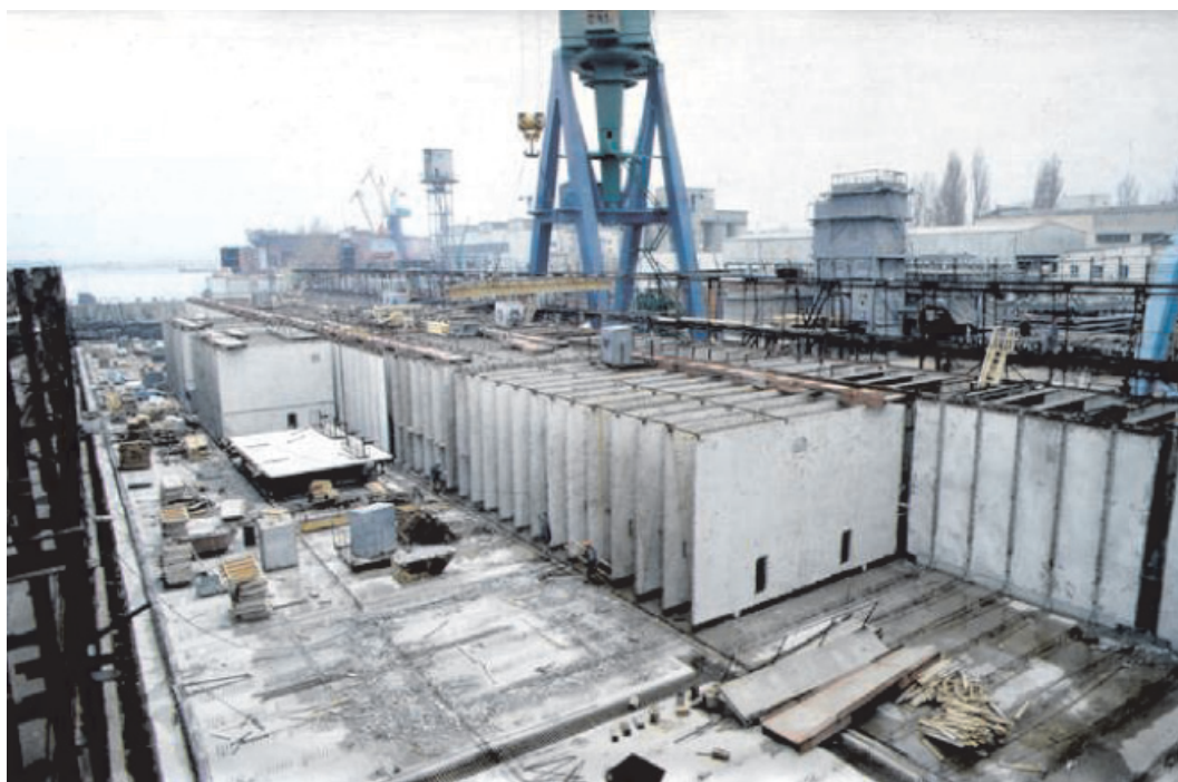
Рис. 9. Установка и раскрепление железобетонных элементов на понтоне плавучего дока подъемной силой 25000 т
