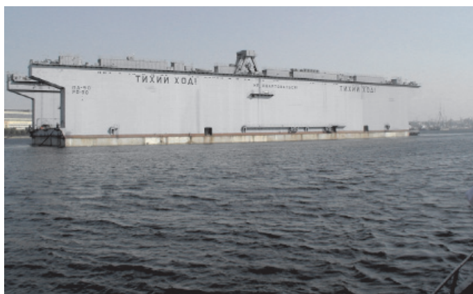
Рис. 5. Ремонтный композитный плавучий док
