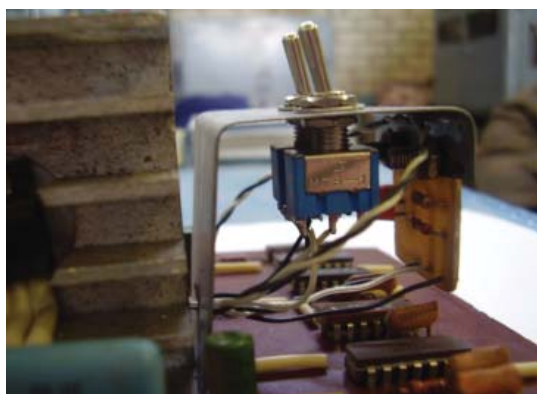
Рис. 4. Фотография установленного блока автоматического управления вибрацией на плату регулятора подачи
